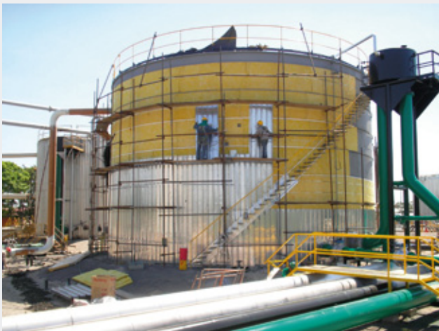
Figura 1. Instalación de INSULQUICK® en tanque de gran diámetro.
