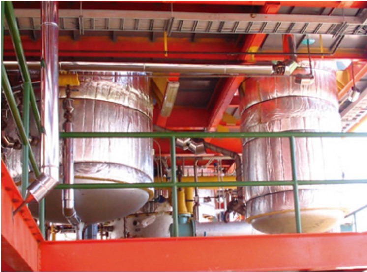
Figura 2. Instalación de FLEXWRAP® en tanques de diámetro mediano.
