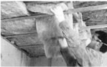
B. Extienda el aislamiento del extremo exterior del ático hacia el centro, esto permitirá tener mayor espacio en el centro, en donde puede realizarse el corte y ajuste, y facilitar el acceso al ático.
