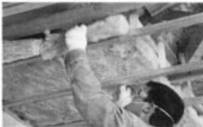
C. La Frescasa debe extenderse suficientemente para cubrir la parte superior de las paredes laterales, pero no debe bloquear el flujo de aire de los aleros o aberturas.
