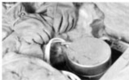
D. La Frescasa debe mantenerse a una distancia de 3" de las líneas de conexión de luz para evitar que éstas se sobrecalienten e incendien. Las 3" de distancia también se deben respetar en entradas de gas o cualquier dispositivo que genere calor.
