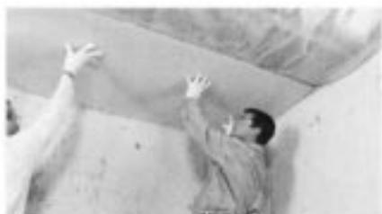
D. Si existe algún dispositivo de alumbrado, la Frescasa debe quedar como mínimo a 3".
