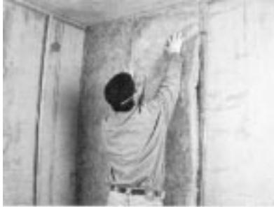
A. Selle todas las entradas de cables o tuberías con sellador de espuma aislante alrededor de los cables o tuberías. Cualquier lugar por donde pueda entrar el aire, permite también la entrada del sonido.
