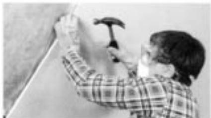
E. Una vez instalada completamente la Frescasa con la barrera de vapor, ésta debe estar totalmente cubierta con un acabado final ya sea en yeso o madera. Las barreras de vapor son inflamables, por lo tanto nunca deben dejarse al descubierto.
