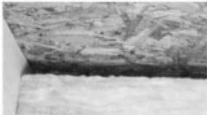
A. Es necesario proporcionar un espacio de 1" para ventilar el plenum entre la cubierta y el aislamiento.
