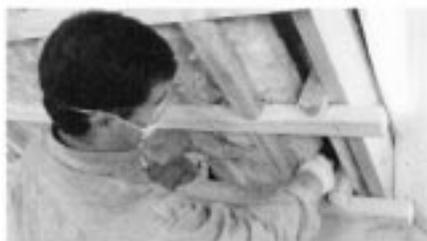
B. Presione el material entre las viguetas hasta lograr nivelarlos. Si la frescasa tiene barrera contra el vapor colóquela hacia el área de mayor temperatura. Siempre se debe colocar la Frescasa sobre un soporte estructural para evitar que se descuelgue con el tiempo.
